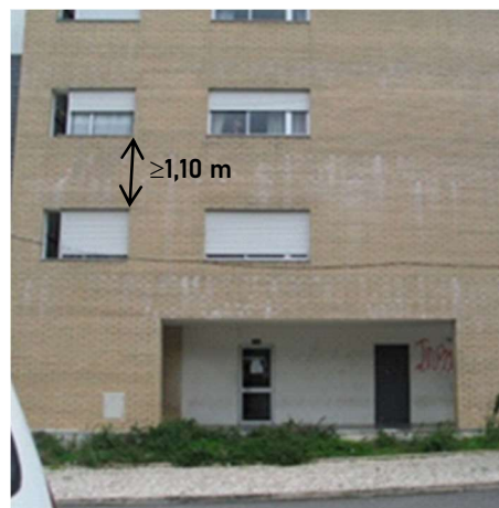
Figura 53 – Vãos situados na mesma prumada, respeitando as exigências regulamentares
