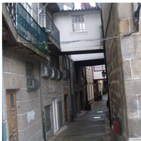
Figura 69 – Via de acesso com reduzida largura e altura livre
