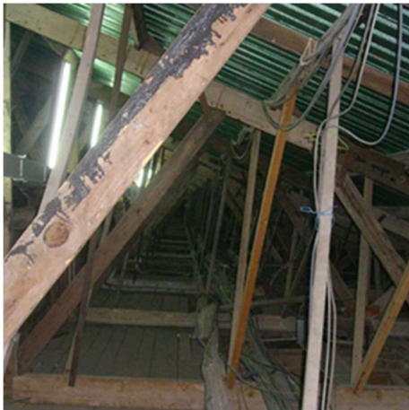
Figura 16 – Aplicação de um produto com baixa temperatura de inflamação sobre um suporte combustível
