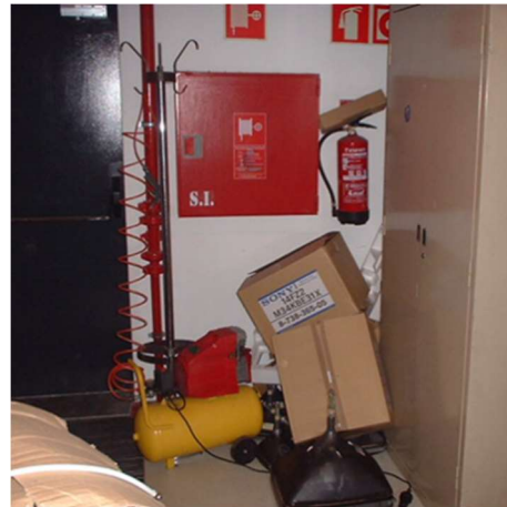
Figura 17 – Desperdícios e materiais dispersos em contato com vários equipamentos
