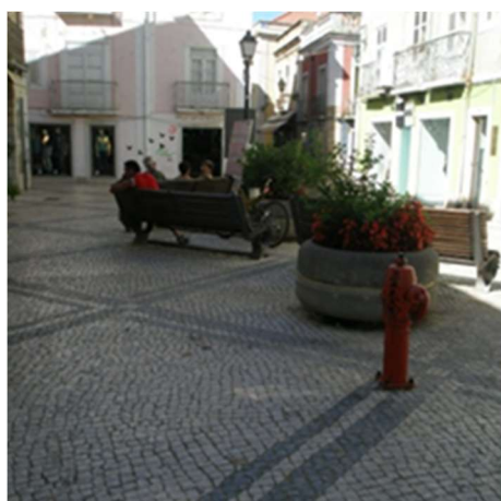
Figura 71 – Acessibilidade prejudicada pelo mobiliário urbano
