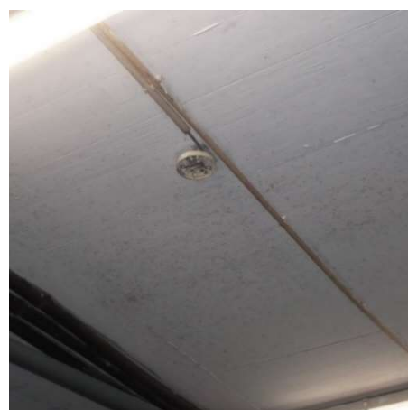
Figura 48 - Detetor danificado
