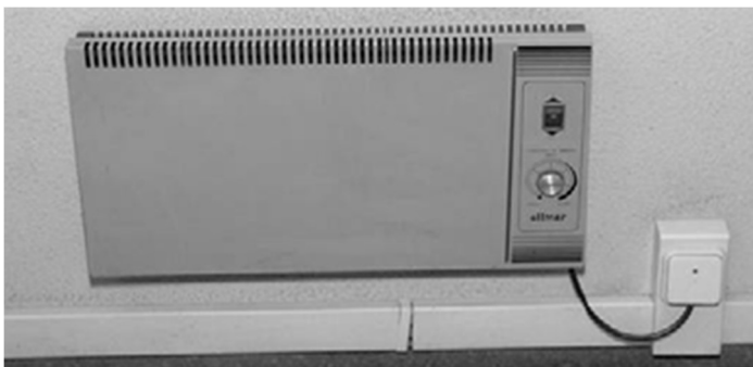
Figura 29 – Aparelho autónomo (devem ser fixados às paredes ou pavimentos em locais de risco B e vias de evacuação)
