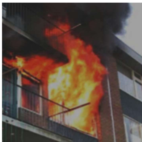
Figura 52 – Propagação do incêndio pelo exterior
