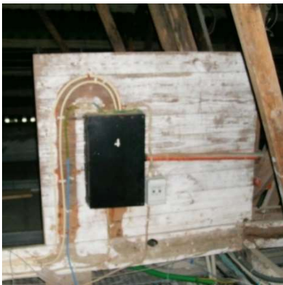
Figura 20 - Instalação de uma caixa de derivação e uma tomada sobre um suporte combustível
