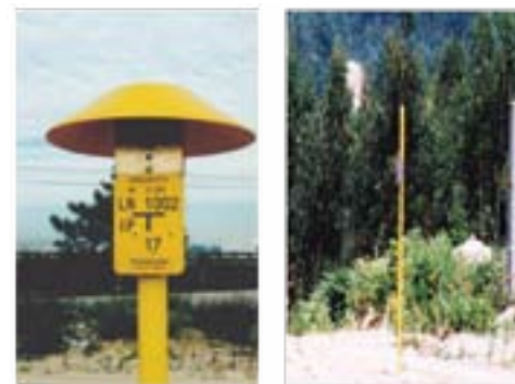
Fotografias cedidas por REN - Gasodutos
