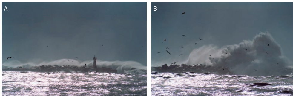
Fotos 5A e 5B: Agitação marítima de tempestade e efeito da refração e da difração das ondas na cabeça do molhe portuário sul da barra do Mondego (7/11/2003).
